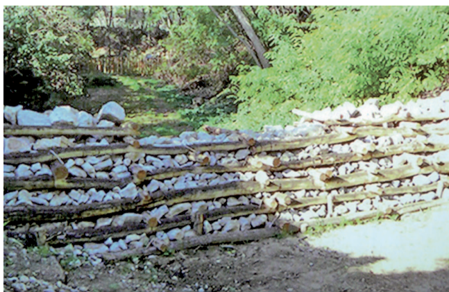
Obr. 4. Kombinovaná dreveno-kamenná prehrádzka pri obci Krivany z r. 2011 (Foto: Lesostav Sever)
