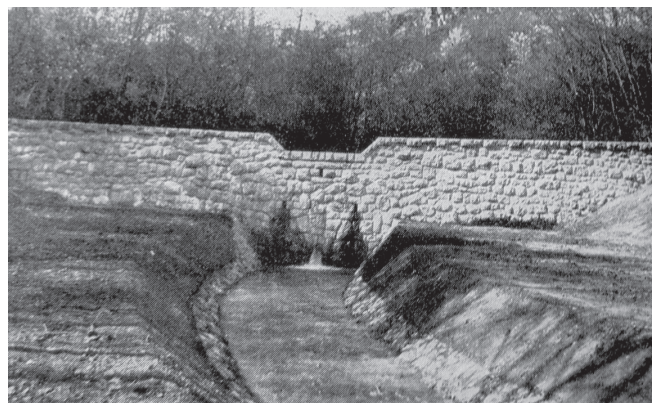
Obr. 1. Kamenná retenčná prehrádzka v Haluzickej strži z r. 1930 (Foto: L. Skatula)
