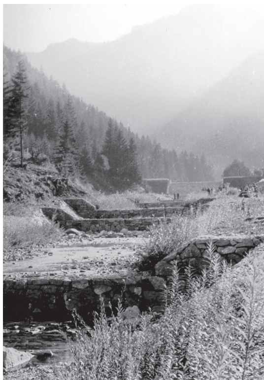
Obr. 2. Sústava drôtokamenných stupňov, v pozadí uzatváracia prehrádzka na úprave Ilanovského potoka v Nížkych Tatrách z r. 1960 (Foto: autor)
