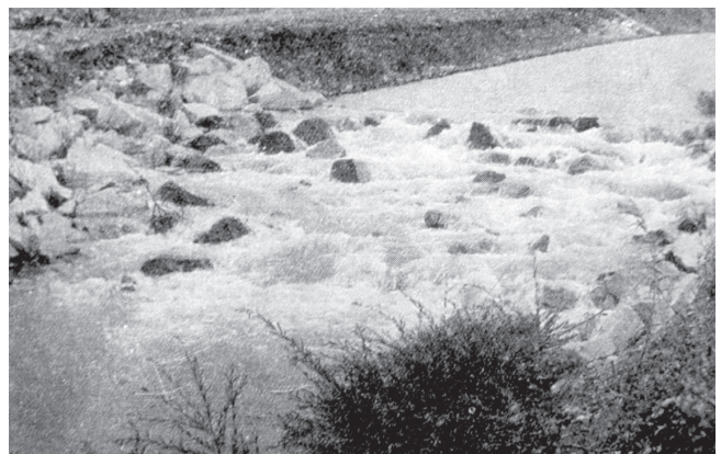
Obr. 3. Sklz s účinne drsným povrchom na úprave Belanského potoka vo Veľkej Fatre z r. 1964 (Foto: autor)
