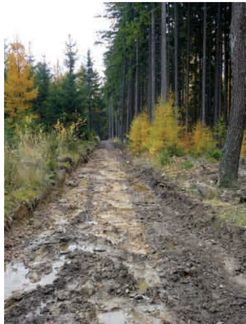
Obr. 2. Čerstvě sanovaná a upravená linka Fig. 2. Repaired and adjusted line.
